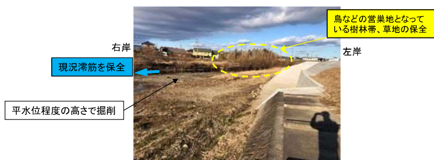
滞筋の保全、水際植生の状況(JR太多線下流)
