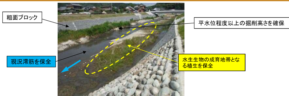
環境に配慮した護岸、水際植生の状況(久々利橋付近)
