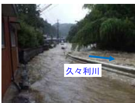
久々利川の浸水状況 (6k150付近)
