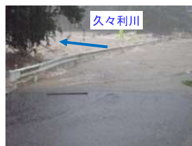
久々利川の浸水状況 (6k260付近)
