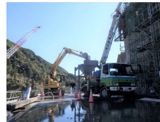
ポンプ打設(造成アバット EL568.75m)
