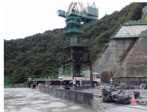
グラントホッパー堤体打設(9BL EL518.75m)
