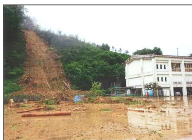
被災箇所（災害発生時：下呂市）
