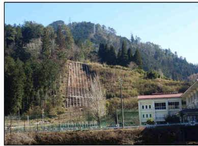
被災箇所（復旧完了時：下呂市）
