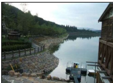
水辺空間整備（護岸工）
