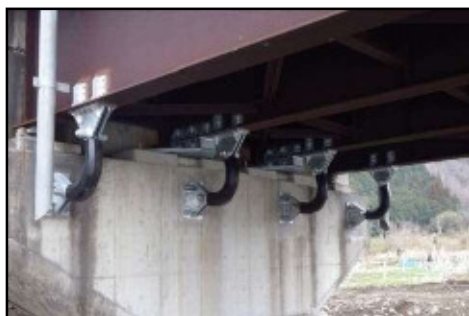
落橋防止装置の設置
