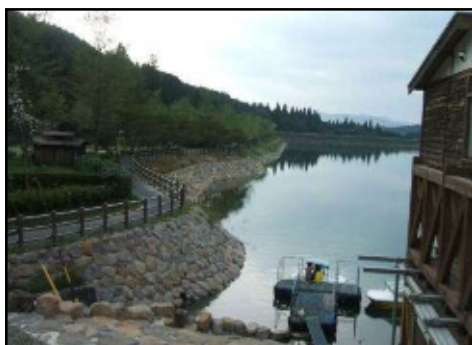
水辺空間整備（護岸工）
