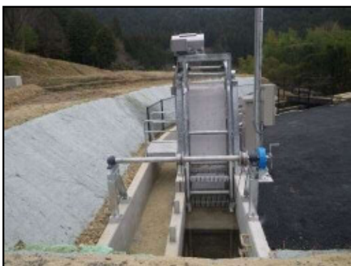
自動除塵機の設置
