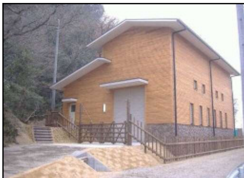
実施後（揚水機場）
