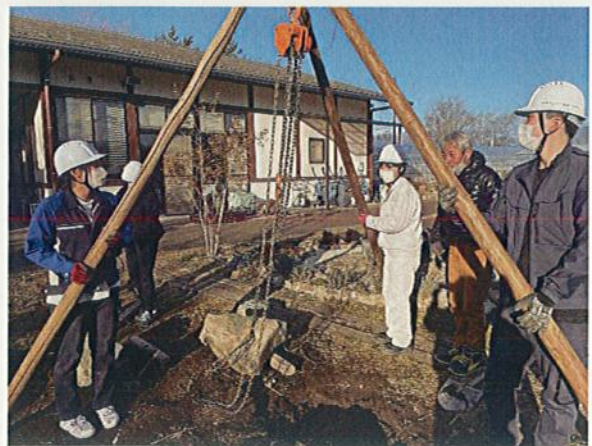
チェンブロックによる景石の据え付け チェンブロックと三又（さんまた）による石の吊り上げ。移動式クレーンが入ることができない造園空間（例えば茶庭）で利用されることが多い。非常勤講師の佐竹康太郎さんによる指導。
