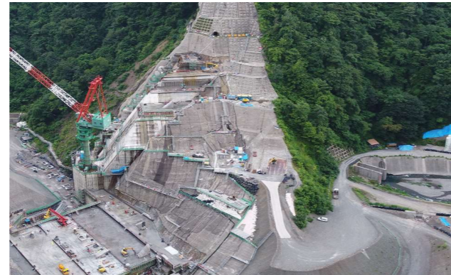
② ダムサイト右岸状況(左岸上空より望む)
