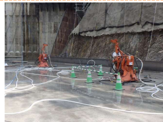
基礎処理工施工状況
