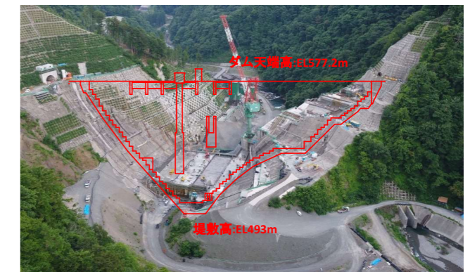
④ ダムサイト状況(上流上空より望む)
