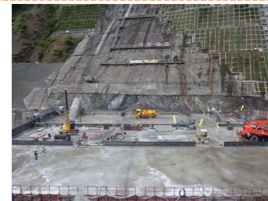
堤体状況(EL510.50m)
