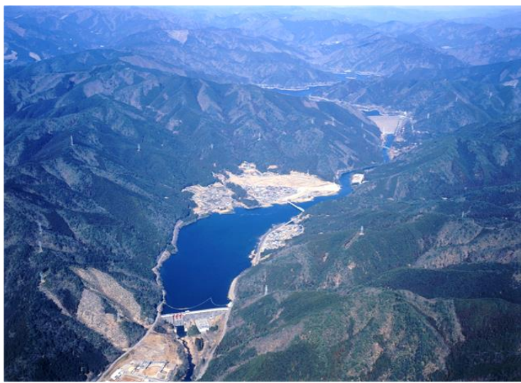
【岩屋ダム】 馬瀬川(下呂市)
