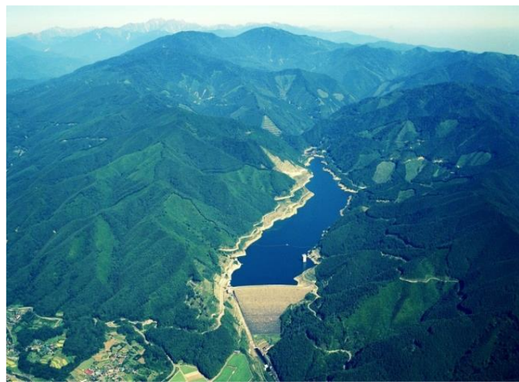
【味噌川ダム】 木曾川(長野県木祖村)
