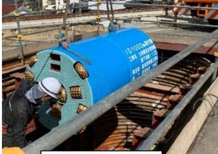
推進工事（恵那市内）
