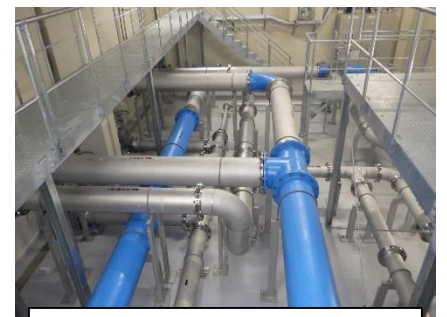
所内配管の整備状況（中津川市内）
