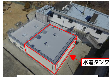
ポンプ所全景（中津川市内）
