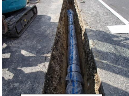
開削工事（中津川市内）
