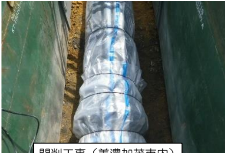
開削工事（美濃加茂市内）
