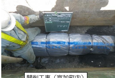
開削工事（富加町内）
