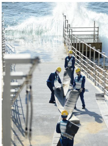
大容量ポンプの接続訓練にて、海水を取水するためのホースを敷設する様子
