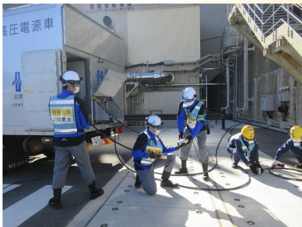
北陸電力の高圧電源車との接続訓練
