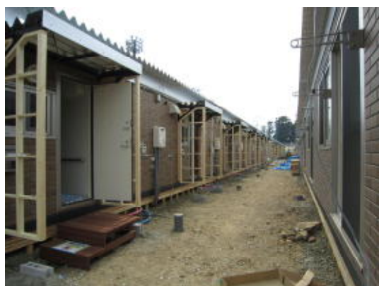
【建設中の仮設住宅（多賀城市）】
