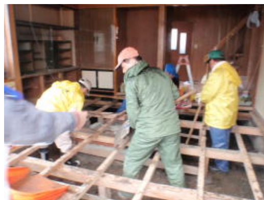
【一般住宅の泥のかき出し作業を行う 県ボランティア隊の様子】 （平成23年4月19日撮影）
