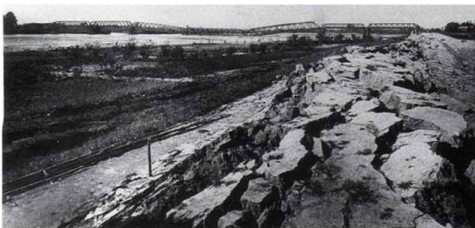
濃尾地震による長良川堤防の被害状況（県歴史資料館）
