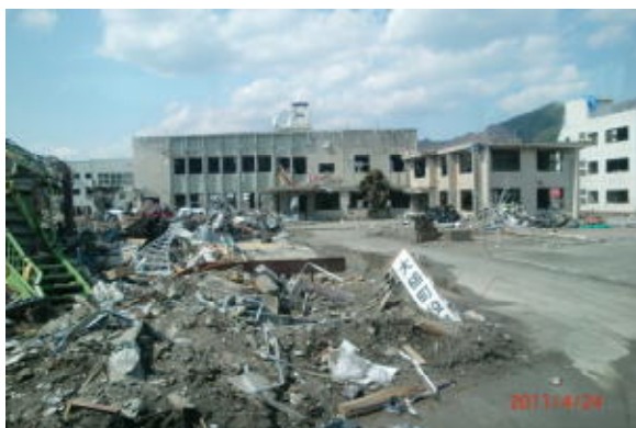
岩手県大槌町役場の被害状況
