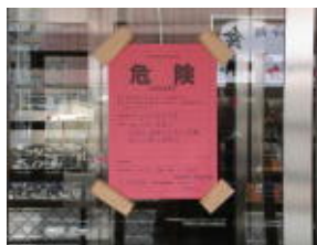
被災建築物応急危険度判定は「危険」とされた
