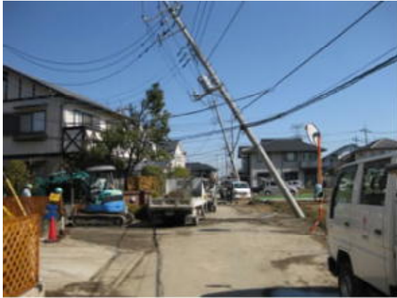
久喜市内被害状況(電柱が大きく傾斜) 画像はいずれも久喜市HPから
