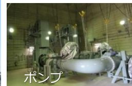
ⓑ緊急時海水取水設備
