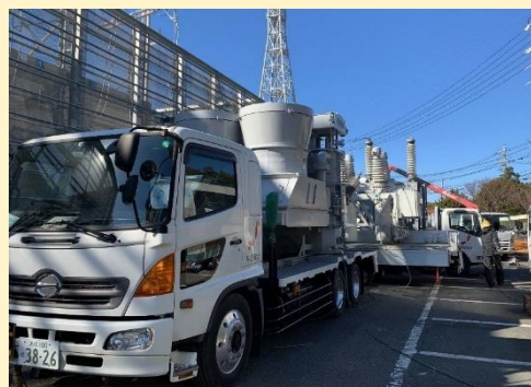
発電所構内に移動用変電設備を設置する訓練
