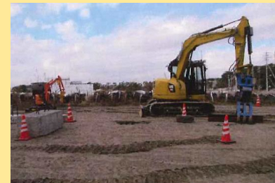
無線重機によるガレキ処理
