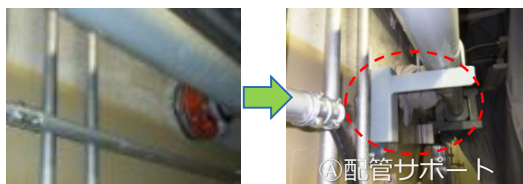
①配管サポート耐震補強
