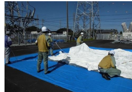
拠点の設営作業
