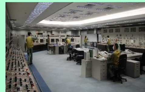
運転員の重大事故対処訓練
