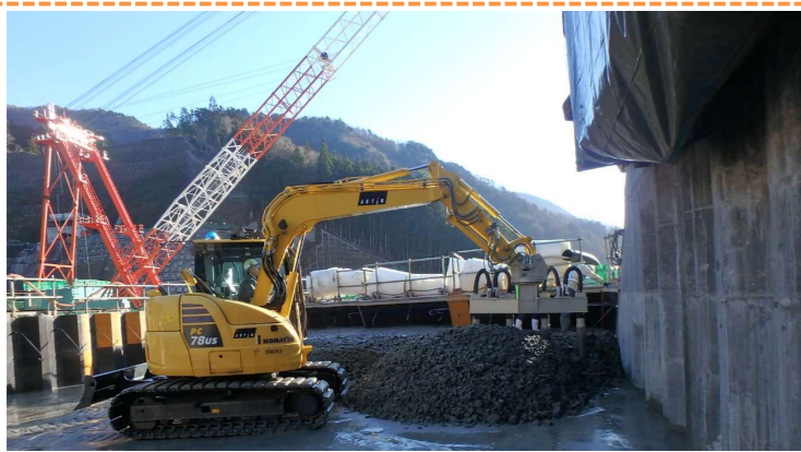
バックホウのバイブレータによる締固め状況
