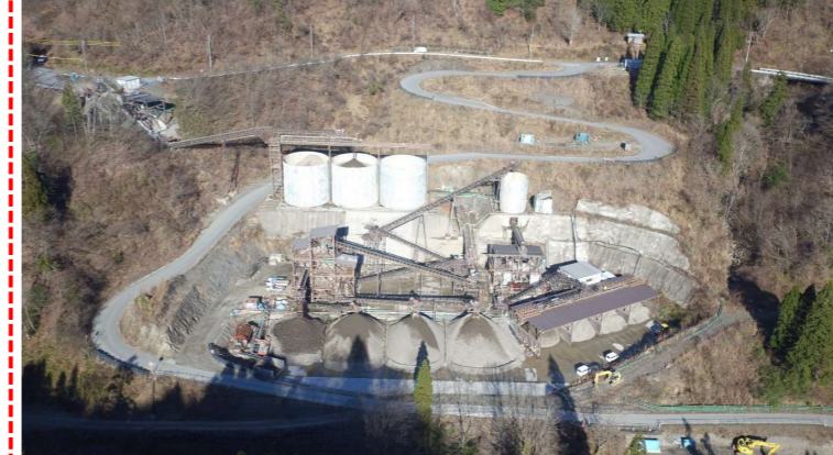
⑤ 骨材製造設備稼働状況
