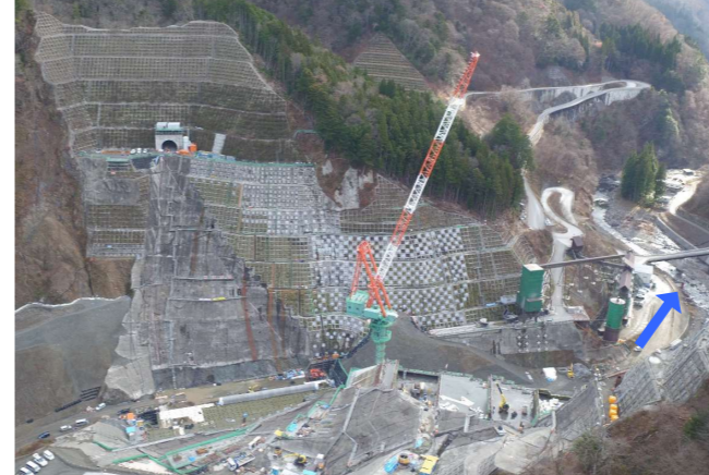
③ ダムサイト左岸状況(右岸上空より望む)
