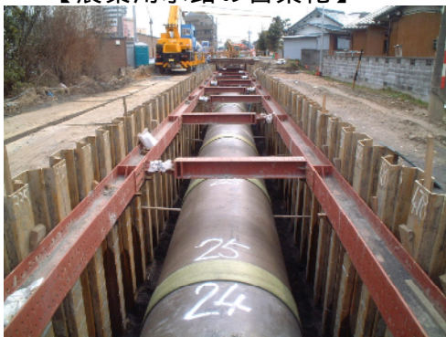
【農業用水路の管渠化】
