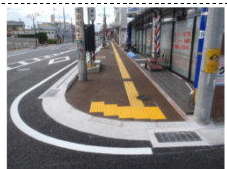
歩道のバリアフリー化 視覚障害者誘導ブロック設置
