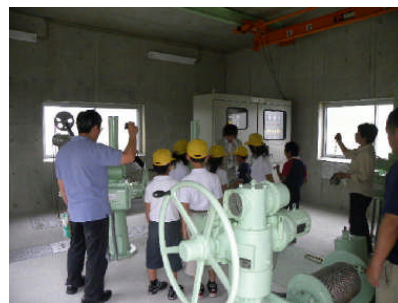
中野方ダム操作室の見学(平成22年6月)
