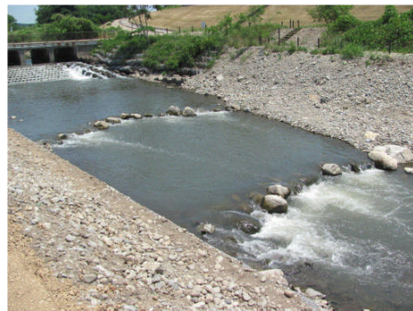
自然石の石組みによる護床工（北派川）
