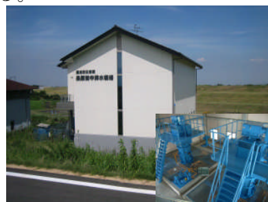
【農業用排水機場の整備】
