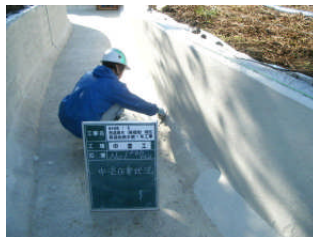
【農業用水路予防保全対策工事の実施】
