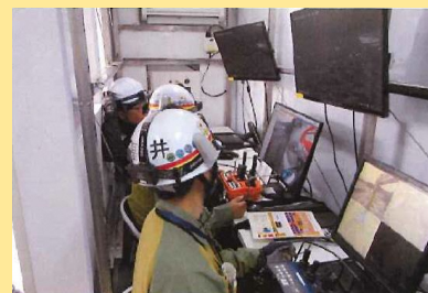
無線重機操作室
