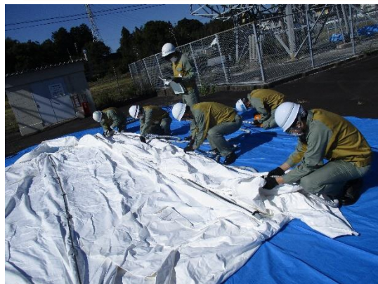
拠点の設営作業
