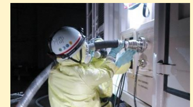
夜間訓練（釜素供給車両への電源接続）の様子
