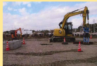
無線重機によるガレキ処理
