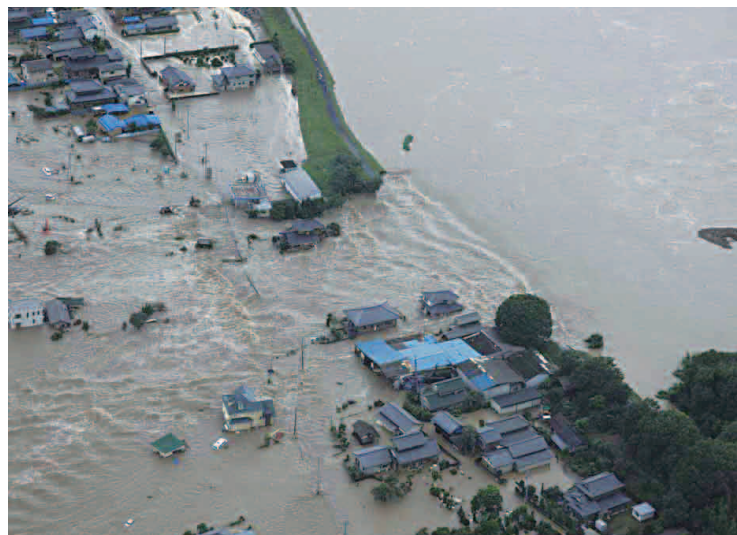
鬼怒川の破堤 平成27年9月関東・東北豪雨災害(茨城県常総市) 写真提供:国土交通省関東地方整備局
