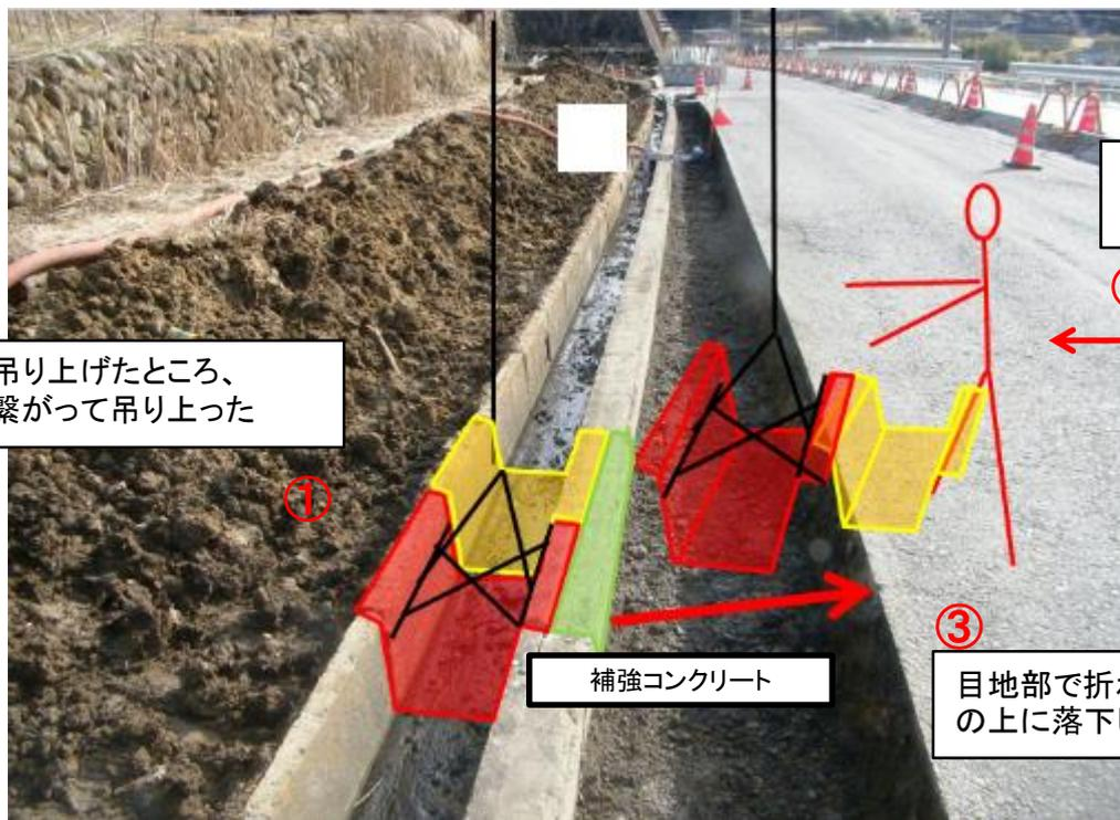
既設側溝(赤色)を吊り上げたところ、次の側溝(黄色)も繋がって吊り上がった
