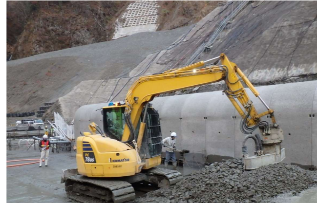
バックホウのバイブレータによる締固め状況
