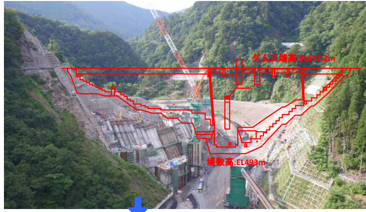
① ダムサイト状況(下流上空より望む)
