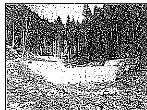
谷止工による荒廃地森林整備（下呂市）
