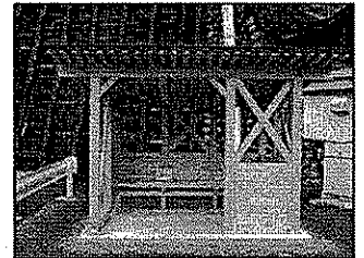
県産材による休憩舎の新設（白川町）
