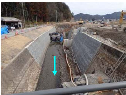
左岸護岸施工中
