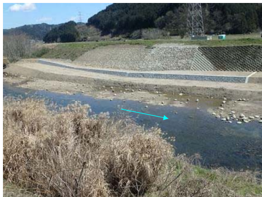
施工後の状況
