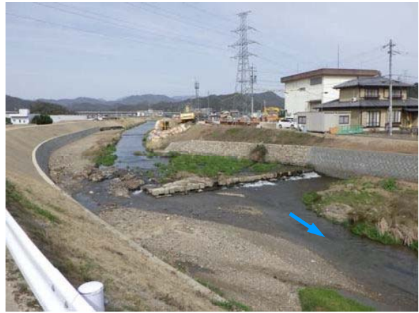
施工後の状況
