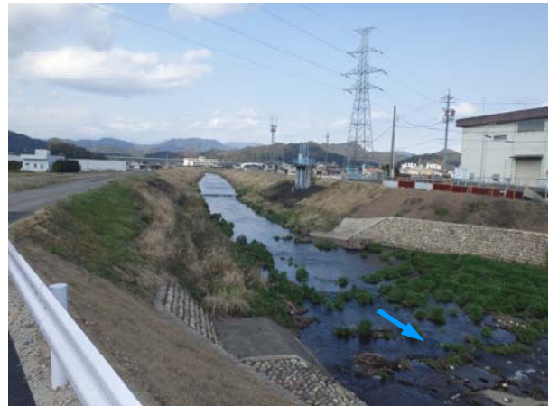
施工前の状況
