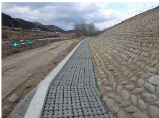
低水護岸施工状況
