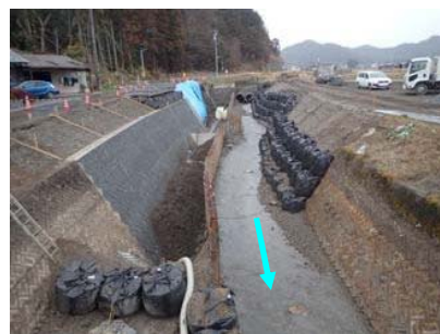
右岸護岸施工中
