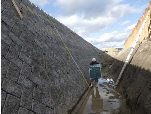
護岸ブロック積施工状況
