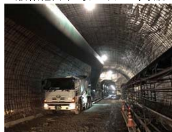
(仮称)冠山峠2号トンネル工事状況
