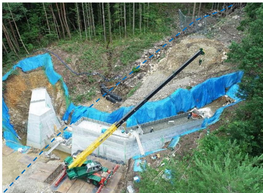
コンクリート打設状況
