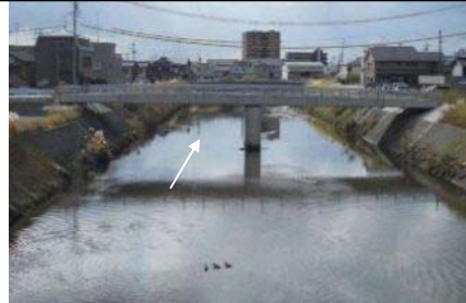
狭窄部であった外輪橋架替と河川拡幅の状況
