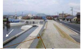
菅野川サイホンの改築と築堤整備の状況
