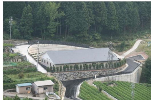
農業集落排水事業 春日地区
