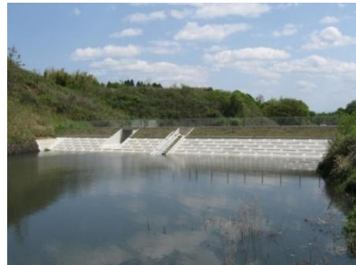
改修したため池(美濃加茂市 小草場地区)
