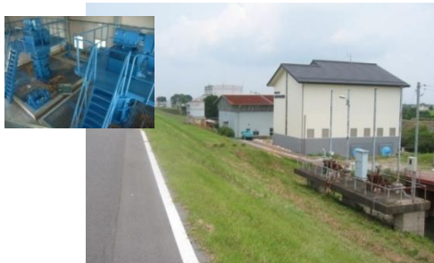
更新した排水機場(羽島市 桑原地区)
