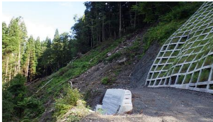
⑤ 下流工事用道路状況
