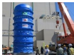
ⓓフィルタバント設備（設置前）
