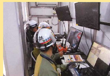
無線重機操作室
