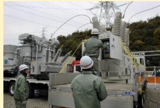
発電所構内に移動用変電設備を設置する訓練
