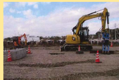
無線重機によるガレキ処理
