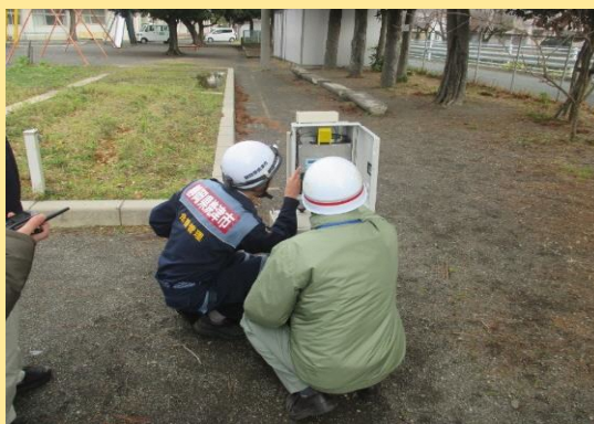
簡易電子式線量計の設置訓練
