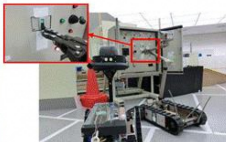
制御盤を開放しスイッチ操作
