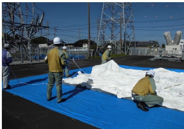
拠点の設営作業
