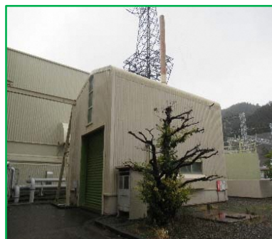
【補助ボイラー建屋】
