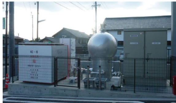
純水素型コージェネレーション燃料電池システム G-FORCE (八百津町)
