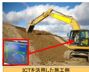
ICTを活用した施工例
