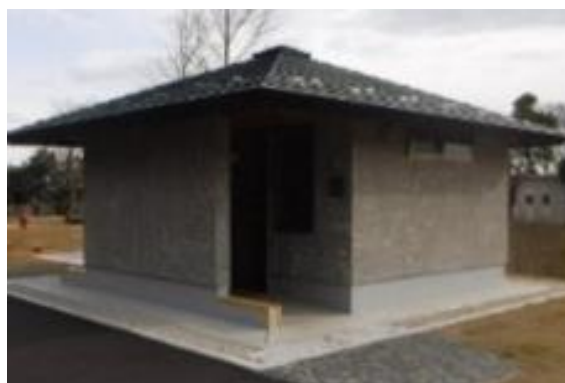
トイレの新設
