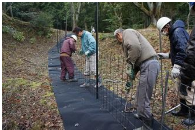
鳥獣防護柵設置状況
