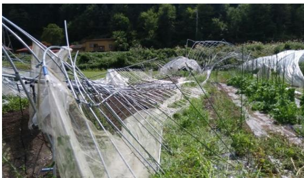
風水害によるパイプハウスの倒壊
