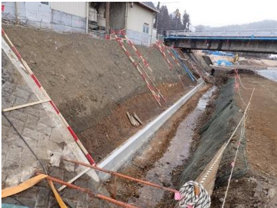
工事用道路設置状況 (令和3年2月26日)
