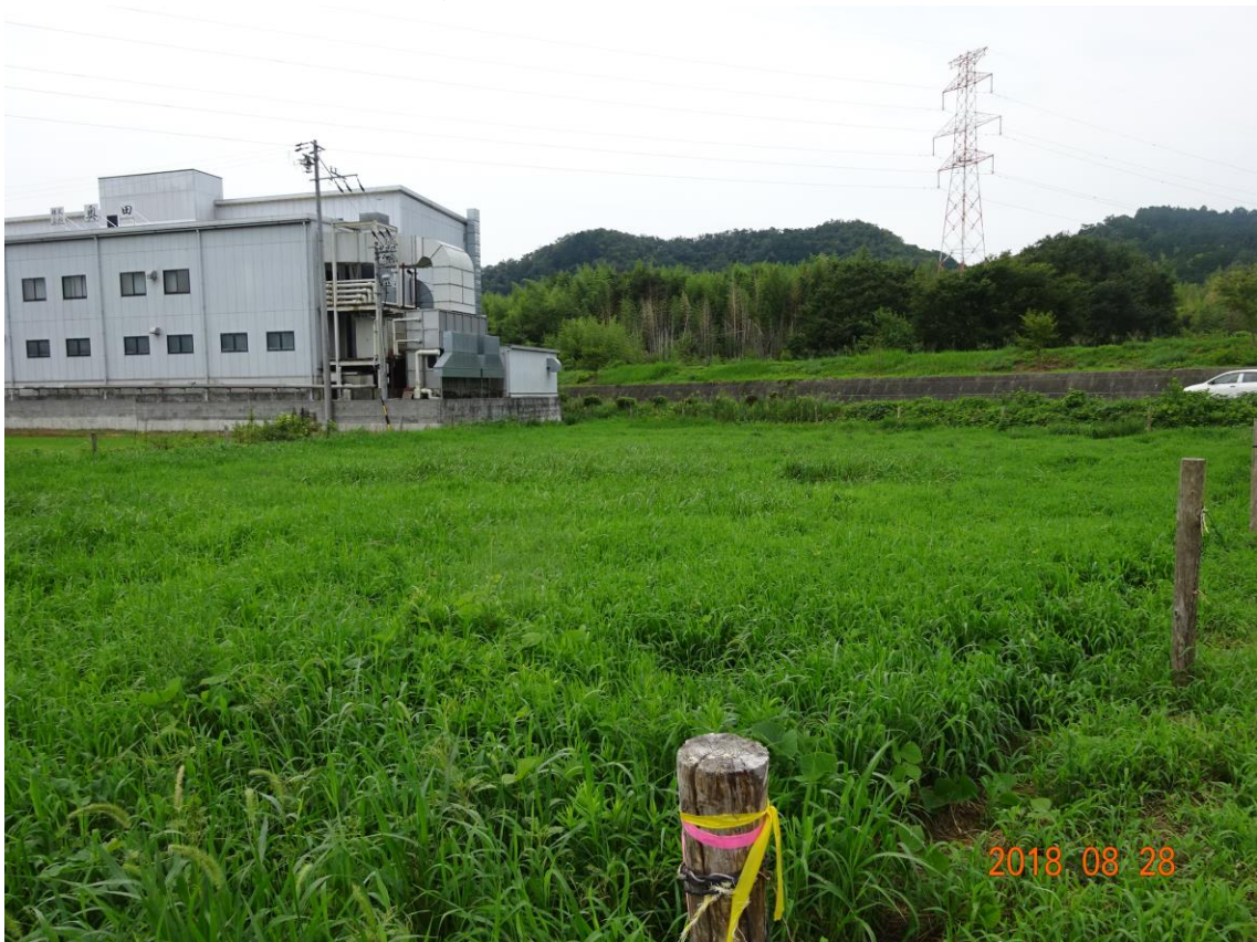
物件北東方向から南西方向を撮影
