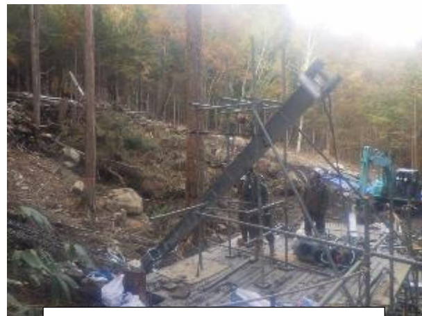
支柱建て込み状況
