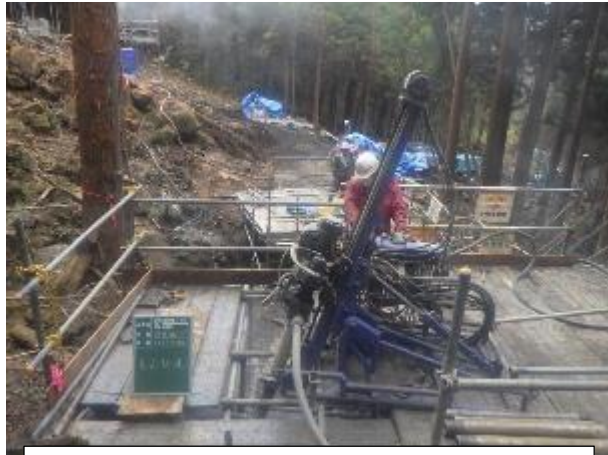
支柱設置箇所の削孔状況
