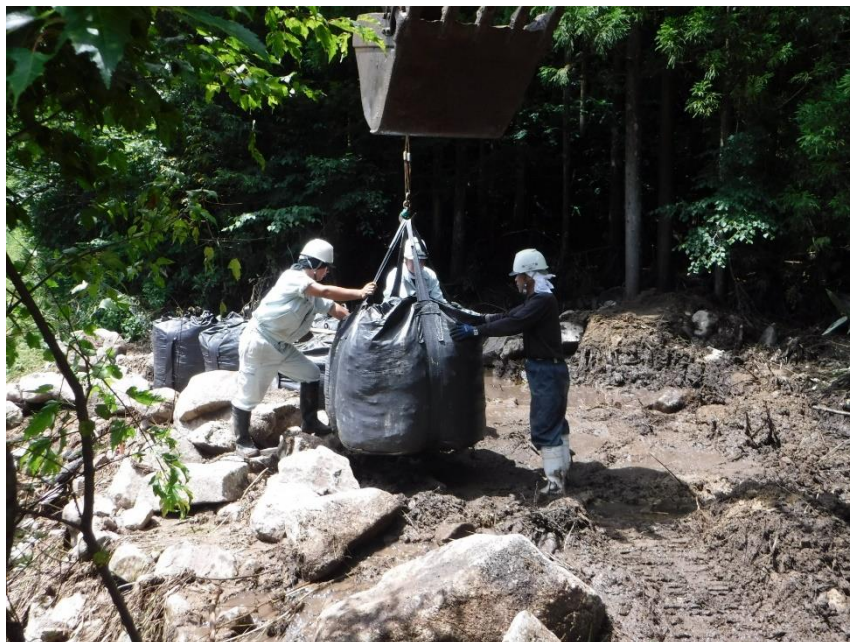
土のう設置状況
