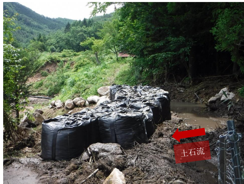
土のう設置完了（令和2年7月21日）
