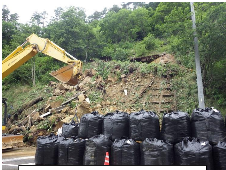
土砂の撤去・土のう設置状況 (令和2年7月9日)
