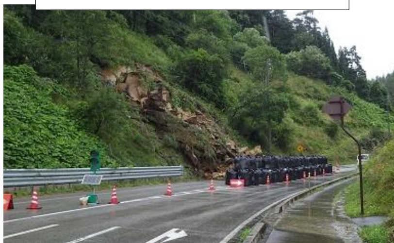
土砂の撤去・土のう設置状況 (令和2年7月9日)
