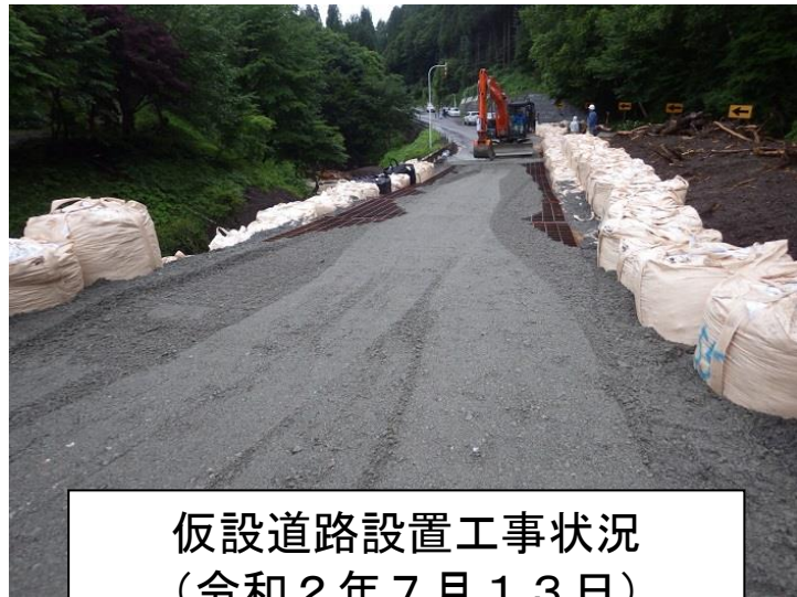
大型土のうを設置し、 さらなる土砂流出を防いでいます。 (令和2年7月9日)
