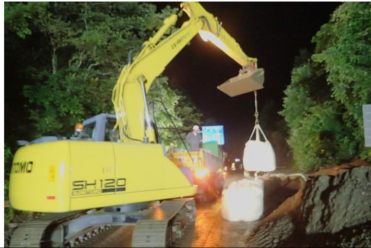
大型土のうを設置し、 さらなる土砂流出を防いでいます。 (令和2年7月9日)
