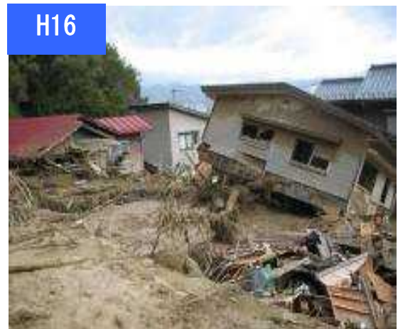
平成 16 年 10 月 20 日 八幡洞：高山市西之一色町
