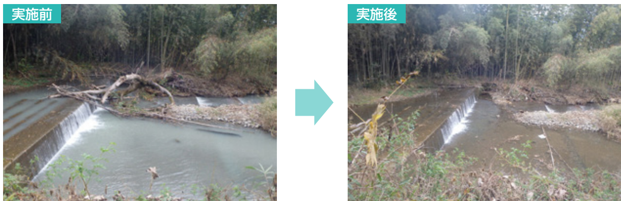
事業実施箇所の状況（不破郡垂井町 相川）
