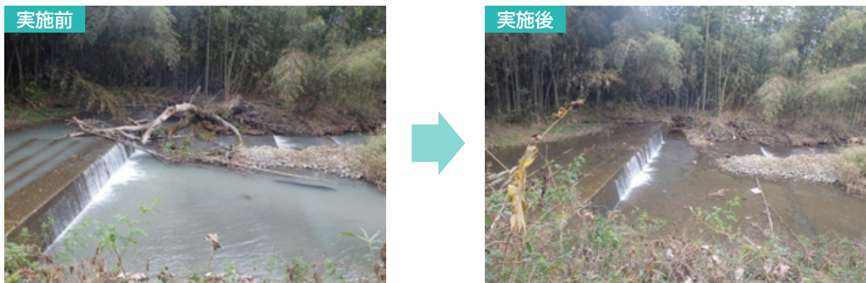
事業実施箇所の状況（不破郡垂井町 相川）
