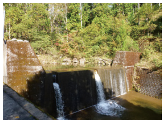
下流の取水堰堤 (東白川村)
