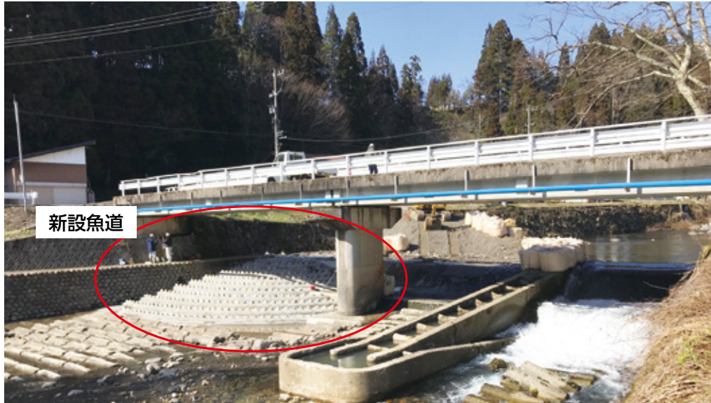
工事中 (完成間近) 魚が遡上しやすい魚道を設置 【前川(郡上市)】
